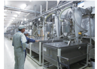
中国・西岑工場の樹脂乾燥設備
