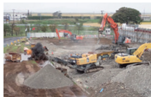
コンクリートをガラパゴス粉砕機で粉砕 (2018年9~8月)
