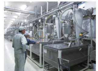
中国・西岑工場の樹脂乾燥設備
