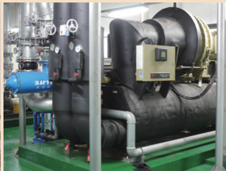
ターボ冷凍機
