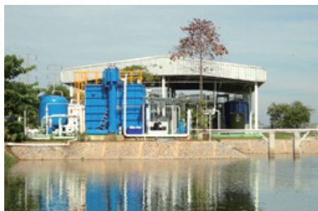
バンパイン工場の雨水池と雨水再利用設備
