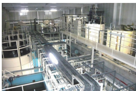
藤沢工場の排水処理設備
