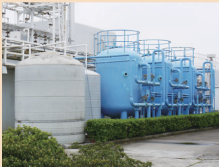
排水処理施設
