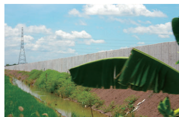
タイのバンバイン工場に建設した堤防
