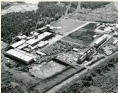
1960年代、拡張工事が続く軽井沢工場
