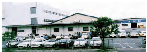
土壌浄化を完了した一関工場
