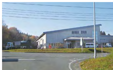
浄化が完了した新金ケ崎工場
