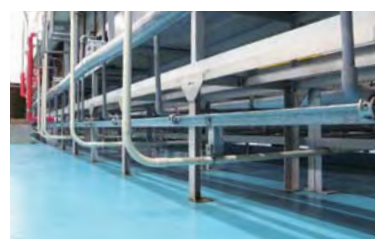
処理槽すべての嵩上げ（見える化の実施）
