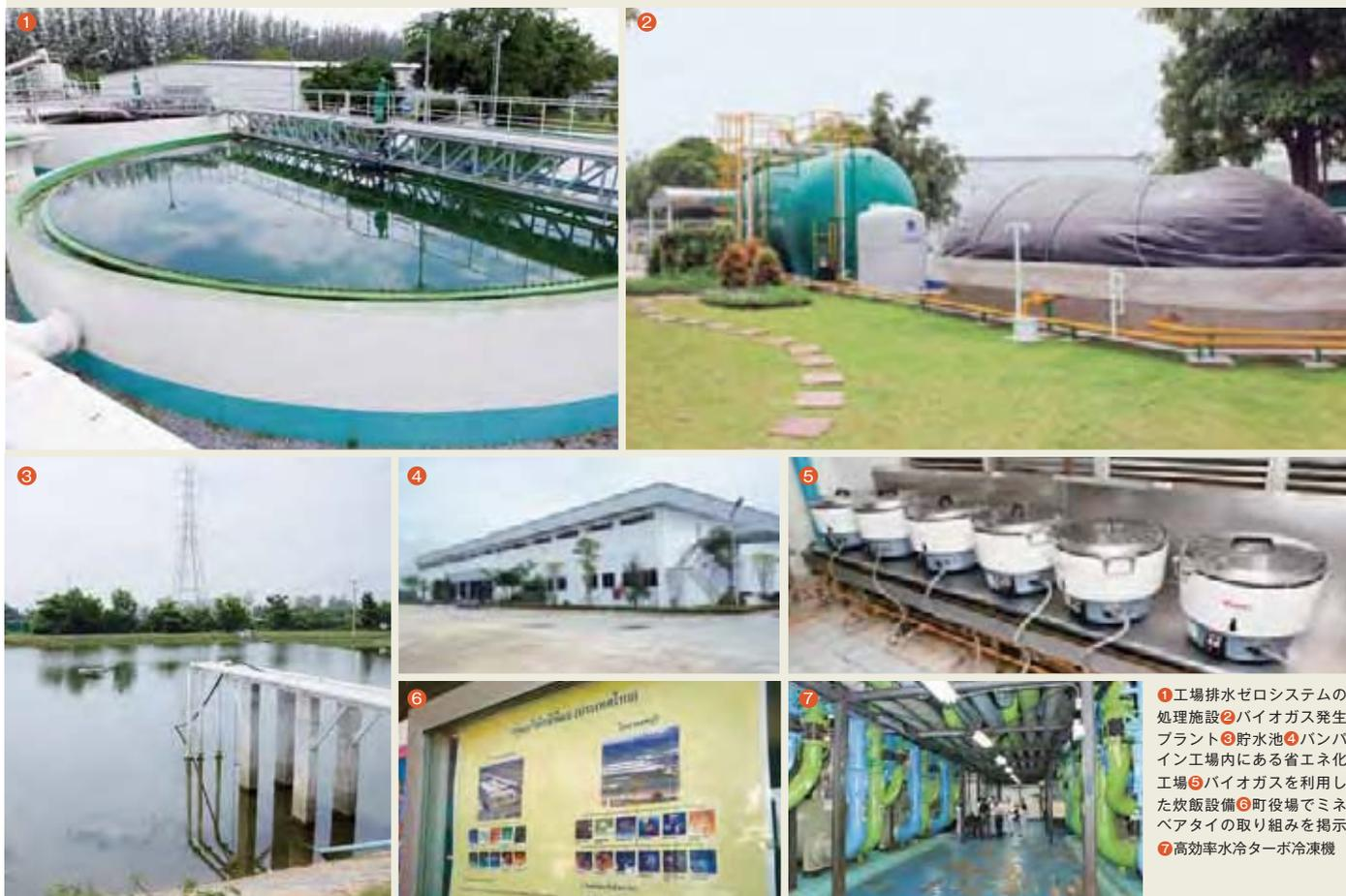
①工場排水ゼロシステムの処理施設 ②バイオガス発生プラント ③貯水池 ④バンバイン工場内にある省エネ化工場 ⑤バイオガスを利用した炊飯設備 ⑥町役場でミネベアタイの取り組みを掲示 ⑦高効率水冷ターボ冷凍機
