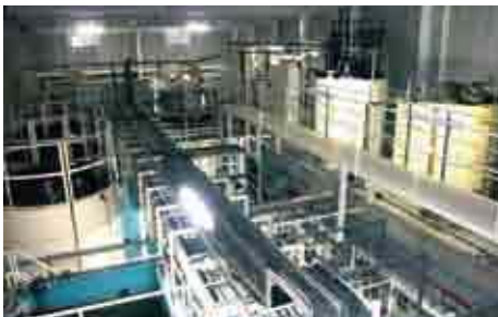
藤沢工場の排水処理設備
