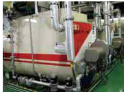
軽井沢工場の都市ガスボイラー
