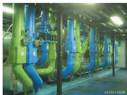
タイのバンパイン工場に導入した高効率タイプの冷凍機
