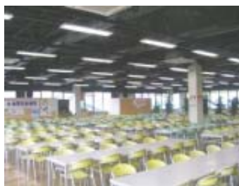
照明器具交換後の食堂
