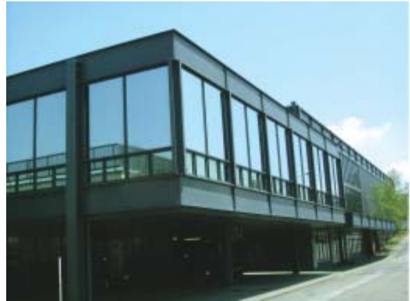
フィルム貼付後の軽井沢工場・食堂棟
