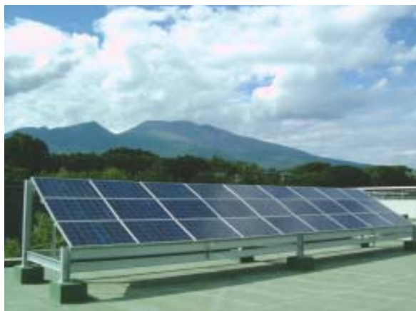
浅間山を背景に屋上に設置された太陽光発電設備
