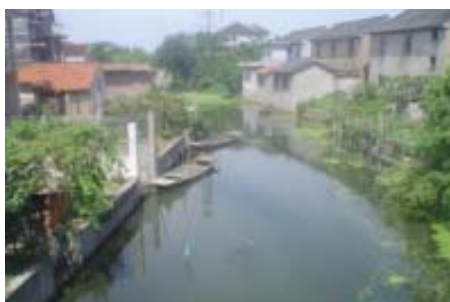
浚渫工事後の河川(1例)
