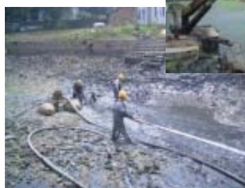
重機による汚泥浚渫後の河底の洗浄
