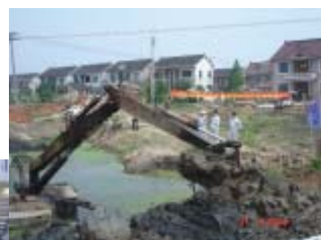
重機による汚泥の浚渫
