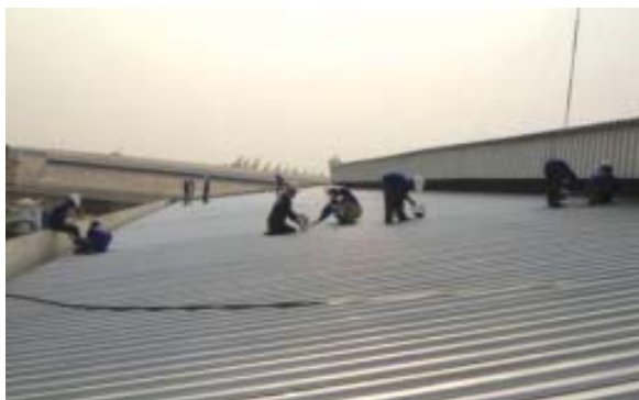
ロジャナ工場屋根の防熱ペイントの施工中
