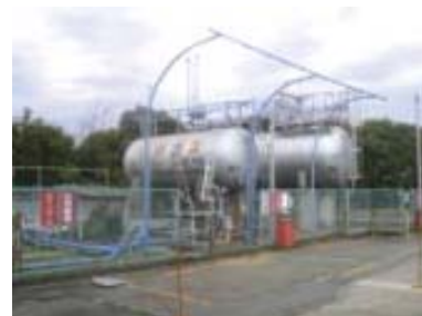
撤去前のLPGプラント
