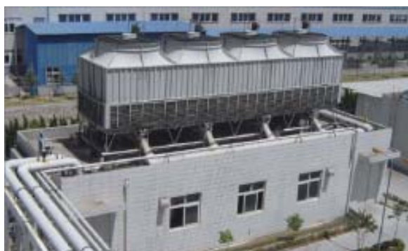
上海順鼎科技有限公司の冷却塔
