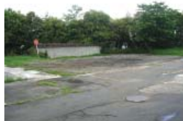
LPGプラント撤去後
