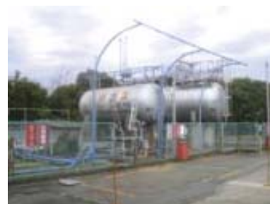
撤去前のLPGプラント
