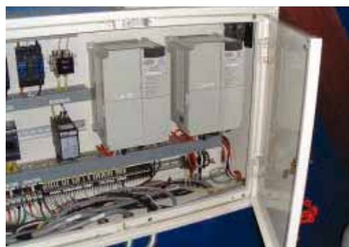
浜松工場の上水ポンプ制御盤に取り付けられたインバーター装置
