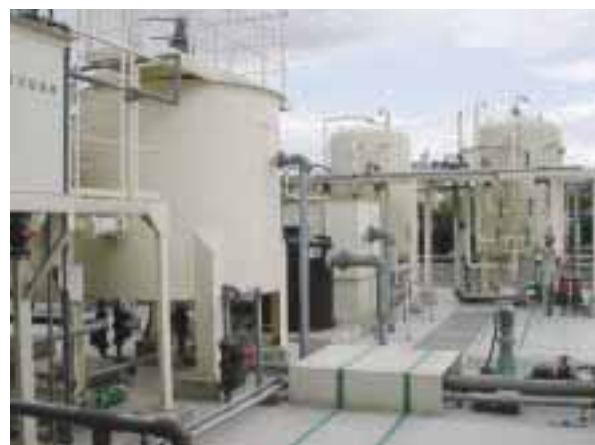
藤沢工場の総合排水処理センター
