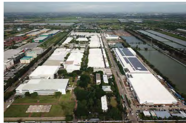
タイ バンパイン工場
