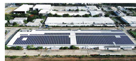
バンパイン工場の太陽光発電
