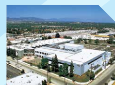
SKF 社リード工場 （米国、現 NHBB チャッツワース工場）
