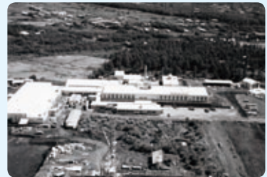
1971年 拡張工事が続く軽井沢工場
