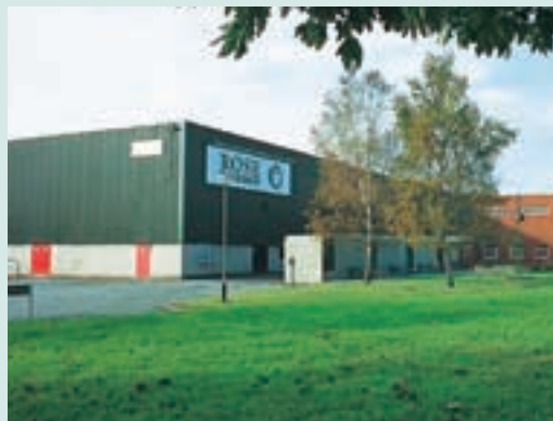
Rose Bearings Ltd. リンカーン工場
