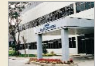
タイR&Dセンター (タイ) シンガポールR&Dセンター (シンガポール)
