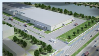
多目的工場（タイバンパイン工場内）
