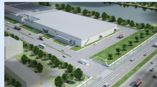
多目的工場 (タイ バンパイン工場内)
