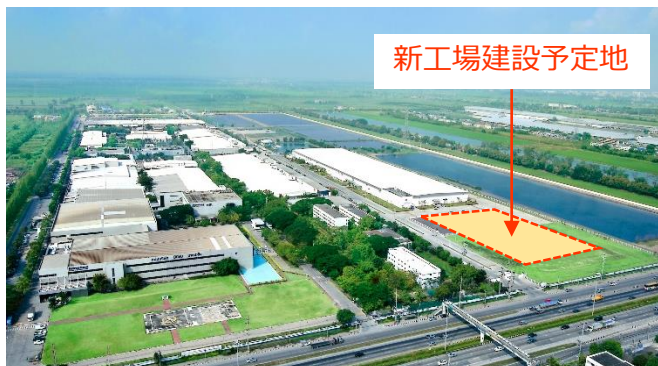
タイ バンパイン工場
