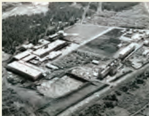
1960年代、拡張工事が続く軽井沢工場
