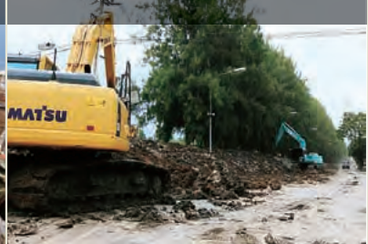
合計45台のショベルカー、ダンプカーを投入した
