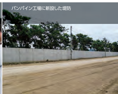
自宅が被災した従業員のため、新ベアリング工場の空スペースを一時避難所とした。避難所の従業員も毎日職場へ出勤し、そして防水作業へ参加した
