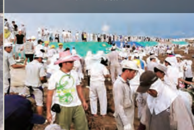
重機で作った土盛りにシートをかぶせた土盛堤防。規模が大きいため、大人数での共同作業となる
