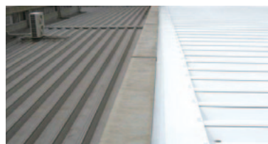
未塗布部 (左側黒色部)、 遮熱塗料塗布部 (右側白色部)
