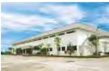
タイ・バンバイン工場内に建設された省エネ化工場
