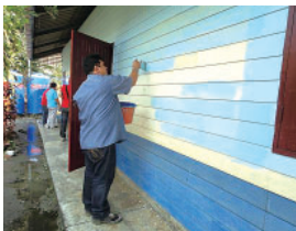
校舎の外壁を塗装
