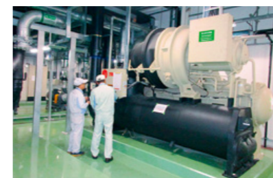
中国・西岑工場に導入されたターボ冷凍機
