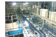
藤沢工場の排水処理設備
