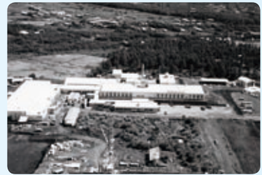
1971年 拡張工事が続く軽井沢工場
