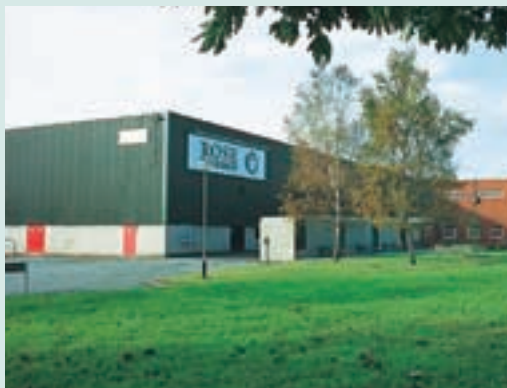
Rose Bearings Ltd. リンカーン工場
